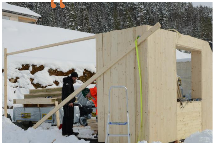
Elementene er tilvirket med høy presisjon og skal kunne bygges nærmest som et Lego-sett på byggeplassen. Dermed skal både byggetiden og kostnadene reduseres i forhold til vanlige byggemetoder.
